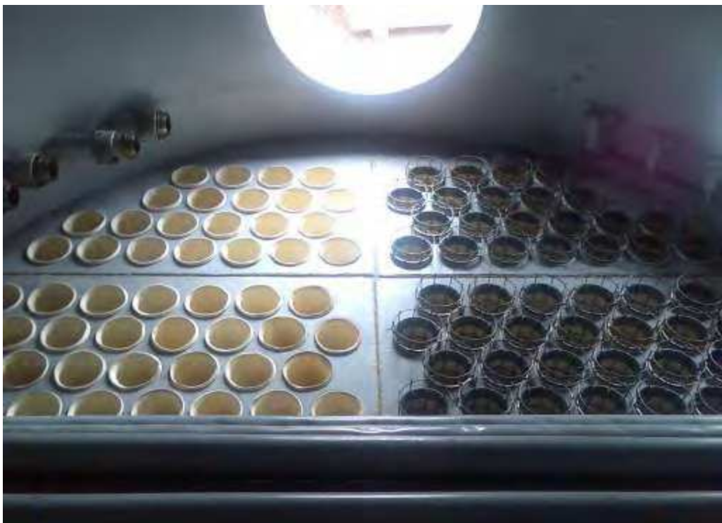
Рис. 5 Внутренний вид камеры «чистого газа»
