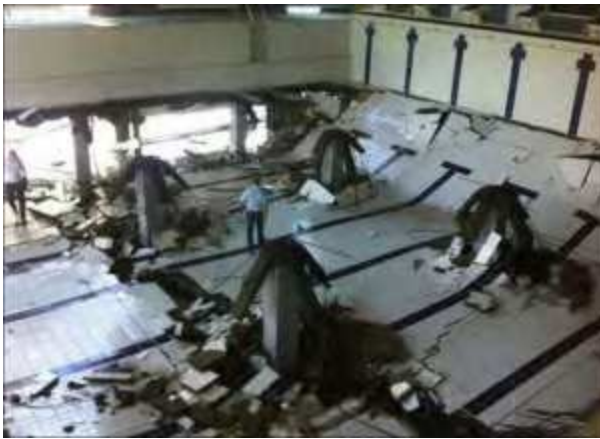
Рис. 1- Результаты разрушения дна бассейна в Краснодаре [1, 15].
