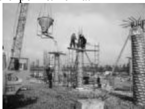
Рис. 9. Подача бетонной смеси в колонну по схеме «кран-бункер»
