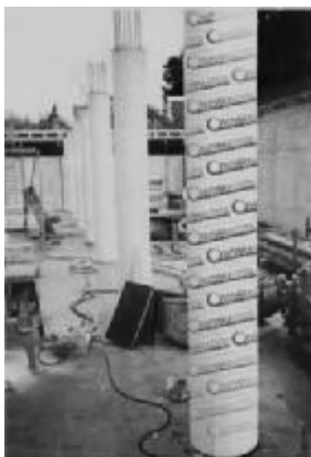
Рис. 2. Возведение монолитных колонн в опалубке из прочного картона
