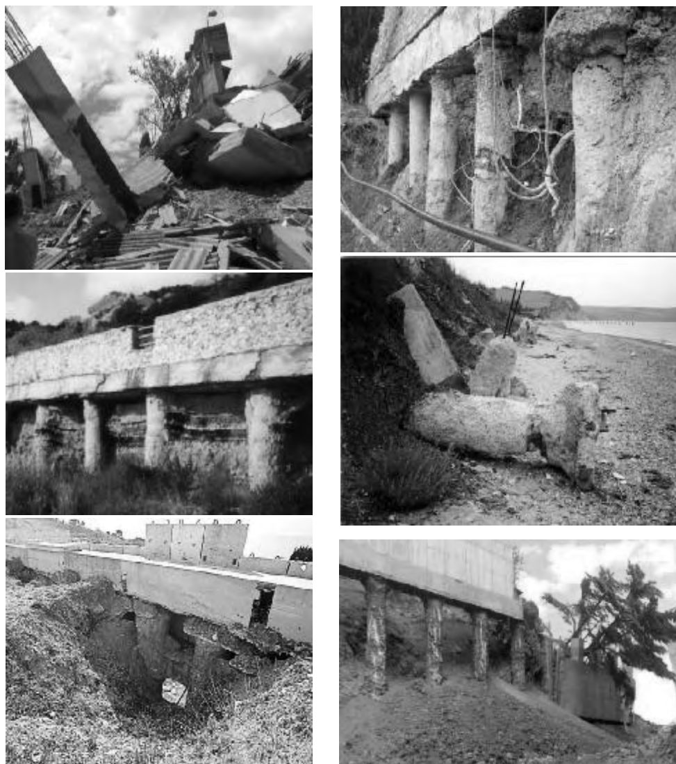
Рис.1. Повреждения системы «массив грунта – удерживающее сооружение – основание» Fig. 1. Damage to the system, "an array of ground - retention structure - foundation"
