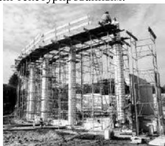
Рис. 3. Возведение монолитных колонн в опалубке KLILA AMICOTUBE
