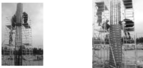
Рис. 11. Установка в проектное положение несъемной опалубки
