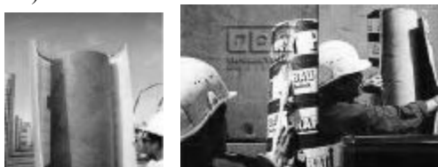
Рис. 10. Демонтаж картонной опалубки
