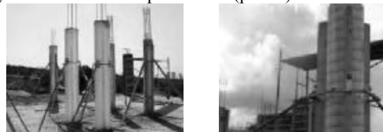
Рис. 7. Временное крепление монолитных колонн в несъемной опалубке в верхней зоне
