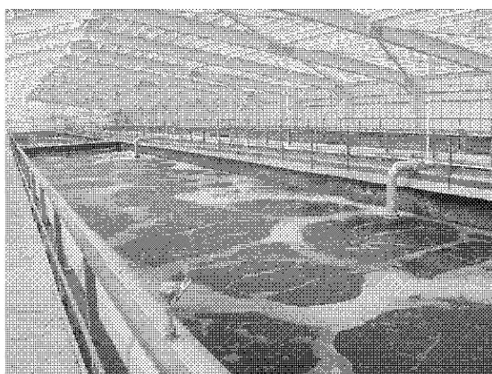
Рис. 6. Крытые сооружения аэротенков в г. Адлер Fig. 6. Covered constructions of aerotanks in Adler
