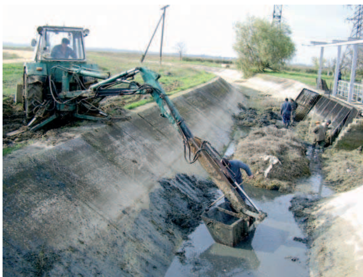
Рис.11 Очистка аванкамеры от наносов Fig. 11 Clearing from deposits
