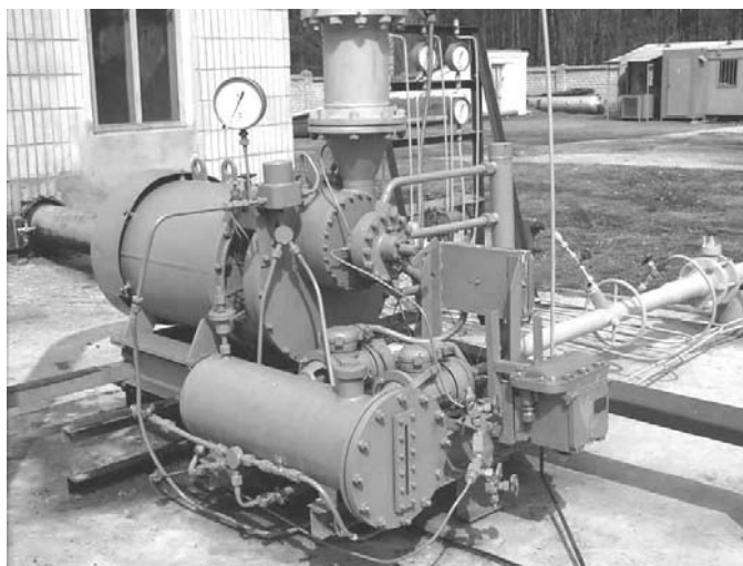
Рис. 2. Агрегат ТДА-СРТ-100/130-5,5/0,6ВРД на "ГРС-1 Сумы"
