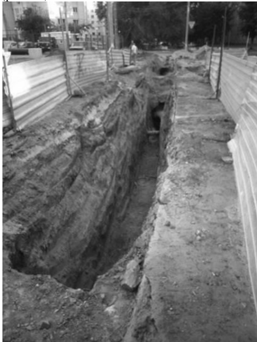
Рис. 11. Открытие траншеи для строительства водопроводной перемычки
