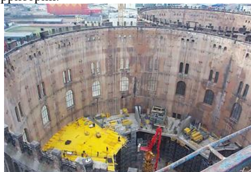
Рис.7. Бетонирование конструкций стен и перекрытий
