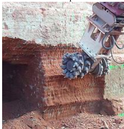
Рис. 6. Разборка кирпичных стен при устройстве дверных и оконных проемов
