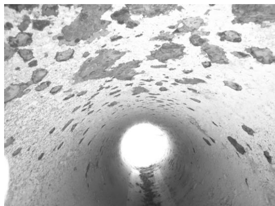
Рис. 4. Внутренняя стенка стального водовода DN 900
