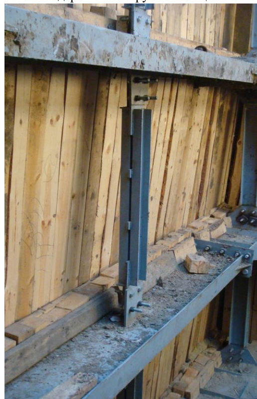
Рис. 7. Крепь для проведения ремонтно-восстановительных работ
