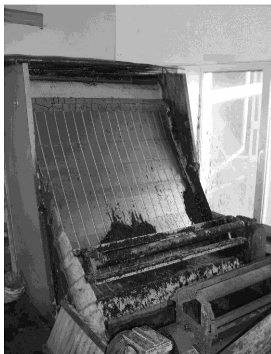
Рис. 3. Дуговое сито марки СД-Ф-50 на очистных сооружениях предприятия «Букофрут» Fig. 3. Arc sieve in wastewater treatment plants enterprise «Bukofrut»
