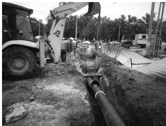
Рис. 11. Монтажные работы сети по ул. Кошкина Fig. 11. Pipe installation by Koshkin str.
