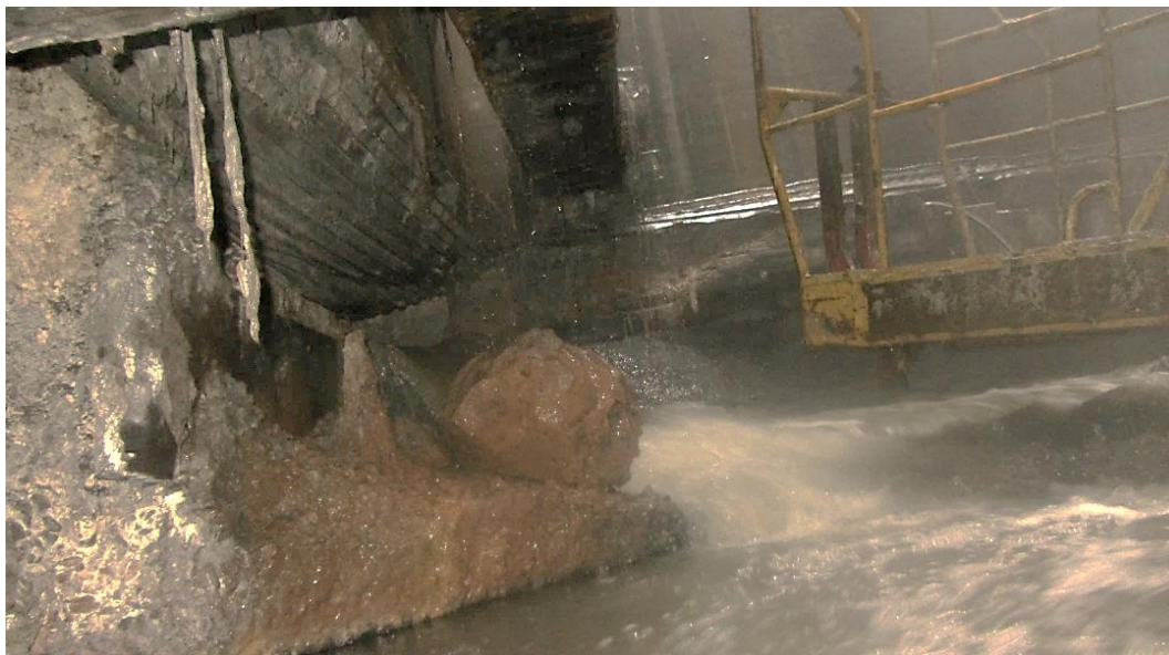
Рис. 4. Дно коллектора в месте падения тубинга
