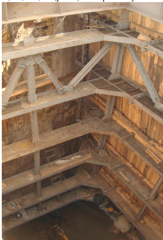
Рис. 7. Крепь для проведения ремонтно-восстановительных работ
