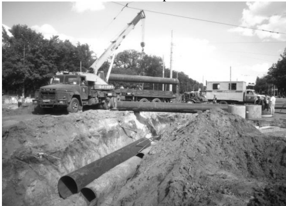
Рис. 6. Монтажные/демонтажные работы восстановления водовода в г. Харькове
