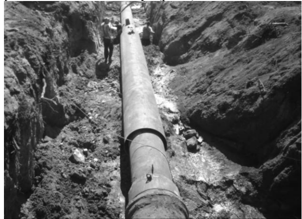
Рис. 8. Монтаж водовода в кожух
