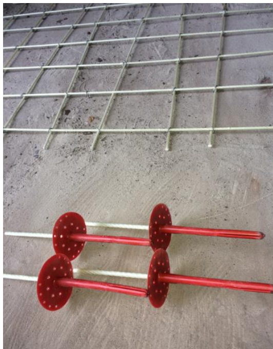
Рис. 8. Армирование стеклопластиковой арматурой сводовой части коллектора
