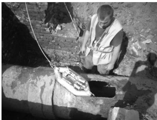
Рис. 3. Телеинспекция водовода DN 900
