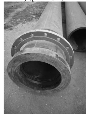
Рис.9. Труба PE100 DN 400 для строительства перемычки по ул. Кошкина
