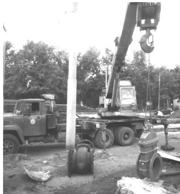
Рис. 15. Замена технически изношенной чугунной задвижки на задвижку с обрезиненным клином Fig. 15. Replacing technically worn iron gate bolted with rubber-wedge
